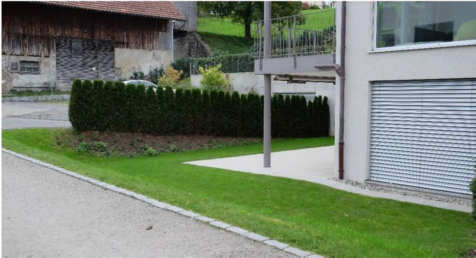
Abbildung 37 Beispiel einer Freilegung des Untergeschosses mittels einer Abgrabung (Quelle: EBP)
