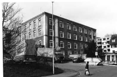
Fabrikbau an der Florhofstrasse
