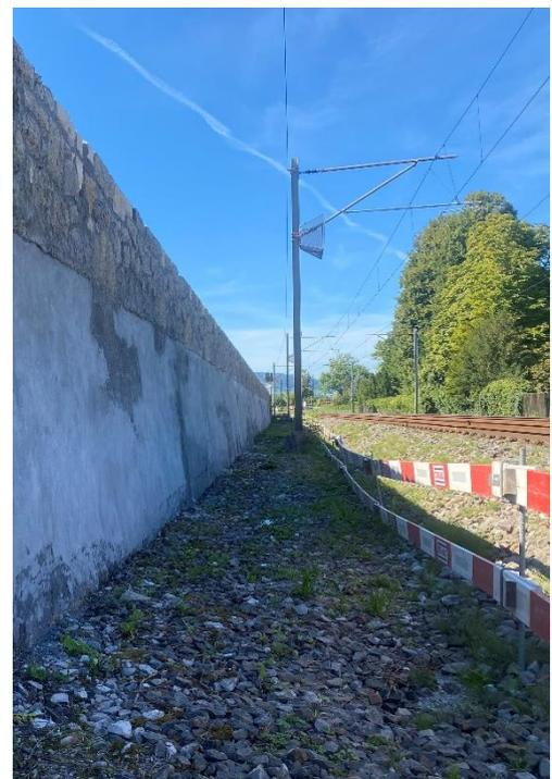
Es musste nicht nur die Brüstung in Handarbeit instandgesetzt werden, sondern auch die von der Strasse aus nicht sichtbare Betonmauer.
