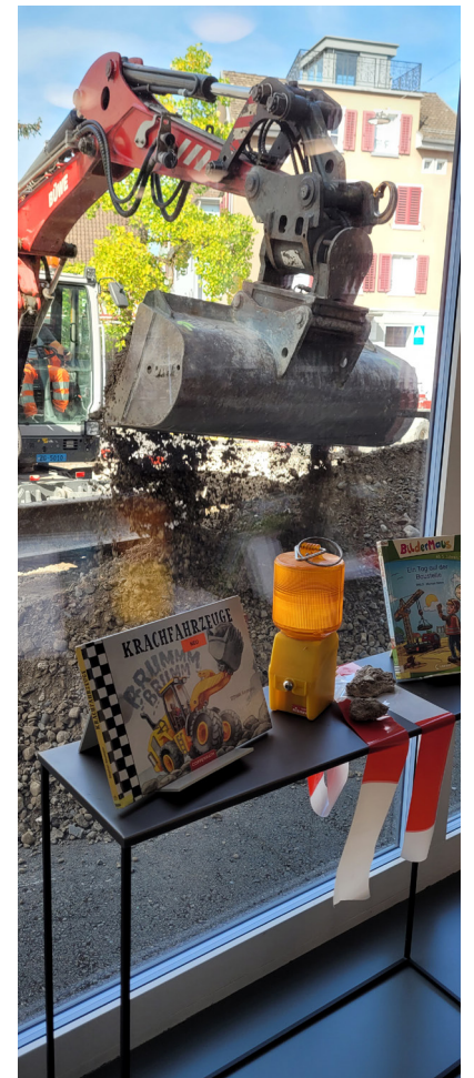
Schaufenster zur Baustelle
