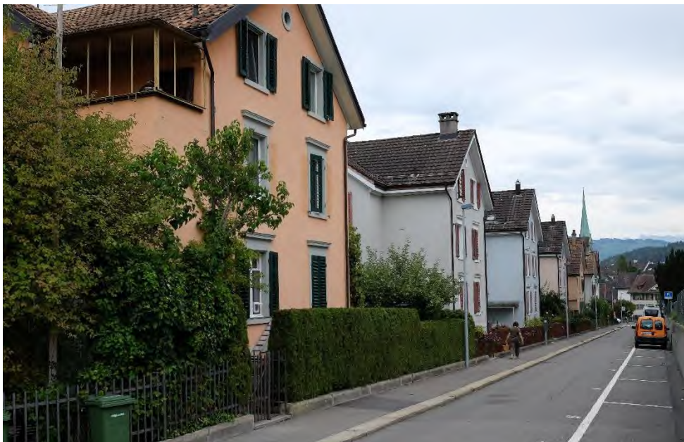
Abbildung 23 Gebäude mit Profilangleichung an der Glärnischstrasse in Wädenswil (Quelle: EBP)
