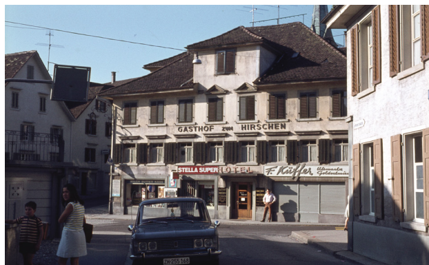
Der Gasthof «Hirschen» an der Ecke Schönenbergstrasse/Zugerstrasse kurz vor dem Abbruch 1975. Das Bild aus der Diasammlung Schoch illustrierte Wädenswil vor 50 Jahren im Jahrbuch der Stadt Wädenswil. Foto: Albert Schoch, Dokumentationsstelle Oberer Zürichsee
