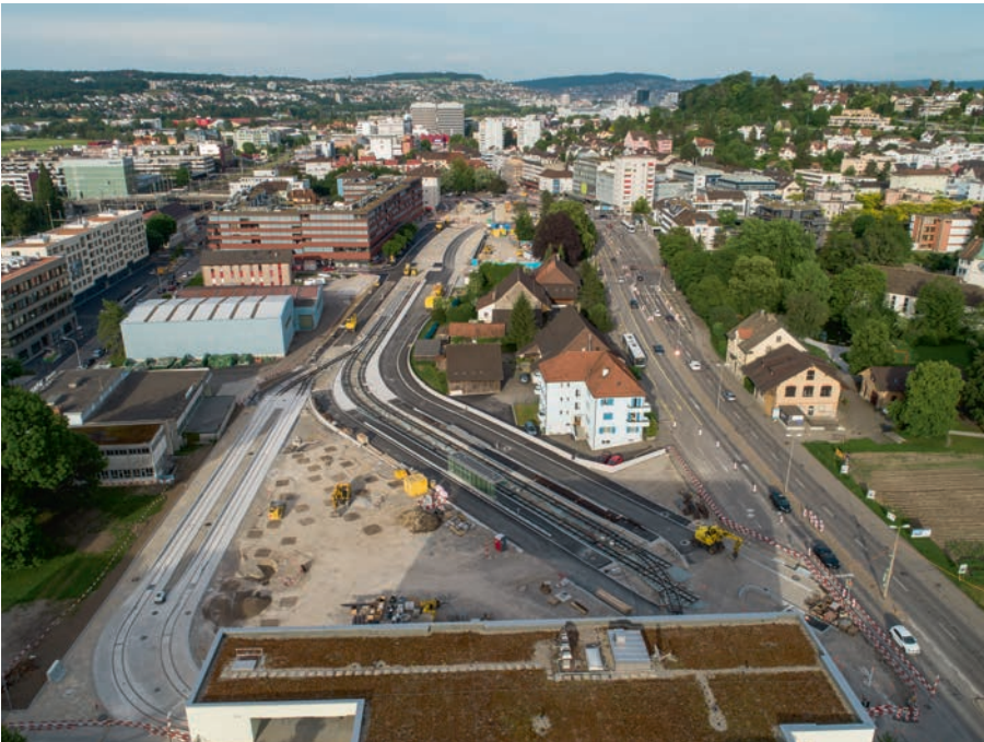
Die erste Etappe der Limmattalbahn zwischen Zürich Altstetten und Schlieren wird bereits gebaut und im Herbst 2019 eröffnet. (Foto: Limmattalbahn)
