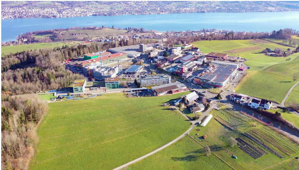
Abbildung 31 Industriegebiet Hinterer Rüti (Quelle: Metron AG)
