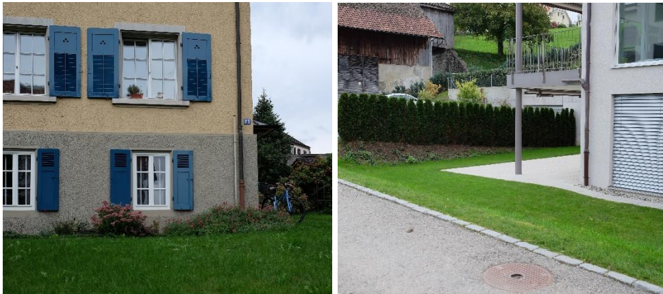
Abbildung 28 Beispiele von Untergeschossen mit Wohnnutzungen (Quelle: EBP)
